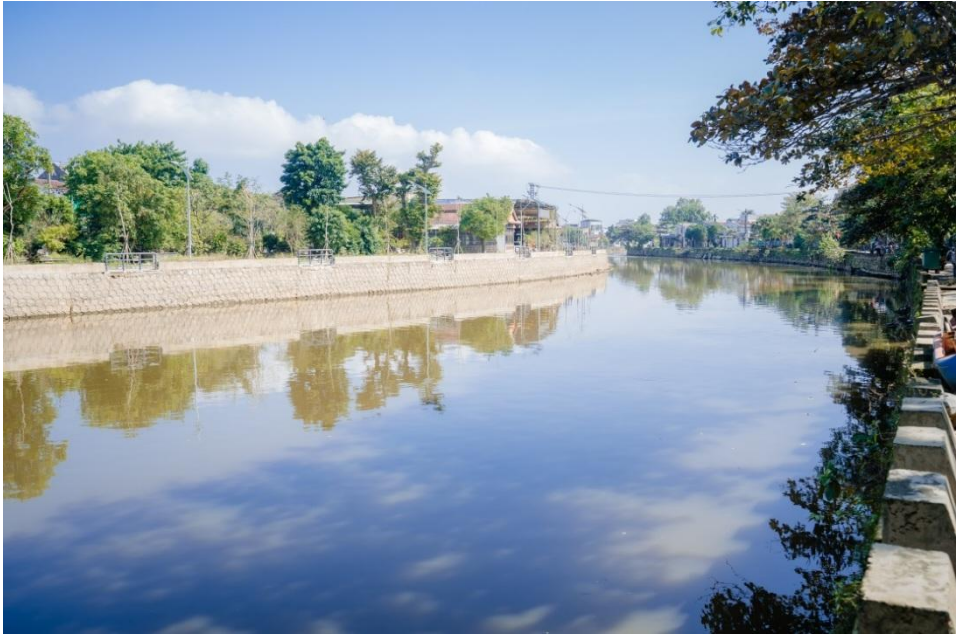
Công trình kè sông An Cựu
